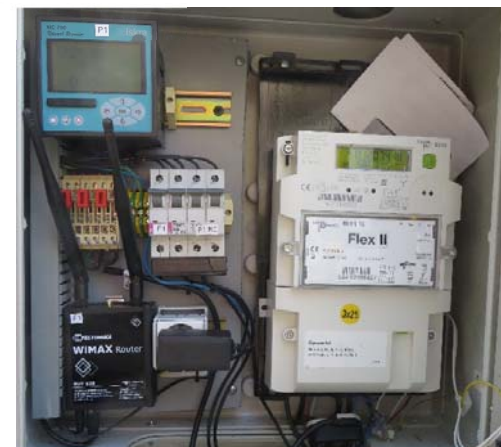
Analizator omrežja ISKRA MC750
